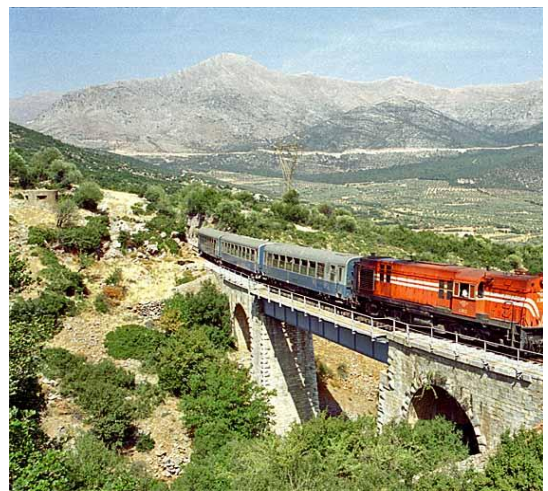
Δηζελάμαξα ALCO στην γέφυρα στην Χ.Θ. 91,6
