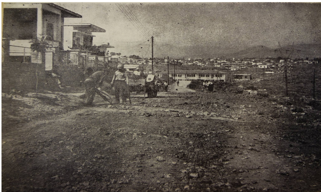
1962: Διάνοιξη της Λεωφόρου Αυλίδος στο συνοικισμό Μασλάτι (νυν Αγία Μαρίνα). Στο βάθος διακρίνεται το σχολείο μας. (Από «Φωτογραφίες Παλιάς Χαλκίδας», Αρχείο κ. Κοσμά Νικολόπουλου)
